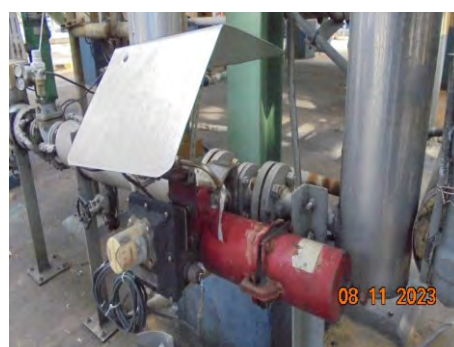
ภาพที่ 2.2-32 อุปกรณ์วาล์วตัดแยกระบบ Emergency Isolation Valve
