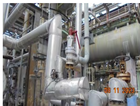
ภาพที่ 2.2-34 อุปกรณ์วาล์วระบายความดัน Pressure Relief Valve
