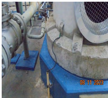
ระบบป้องกันฟ้าผ่า (Ground and Lighting)
