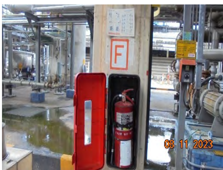
ถังดับเพลิงผงเคมี (Dry Chemical)
