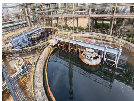
ภาพที่ 2.2-4 ระบบบำบัดน้ำเสีย DAF
