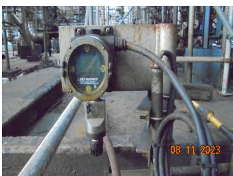
ภาพที่ 2.2-31 อุปกรณ์ตรวจจับก๊าซ Gas Detector
